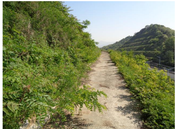
1소단 배수로 전경
