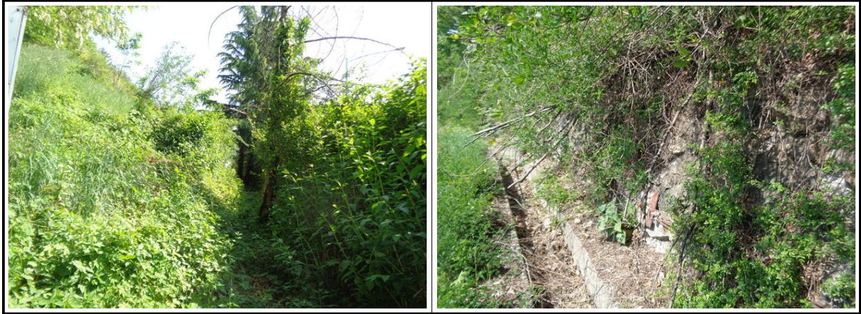
【그림 1.3.4】보호/보강시설 전경
