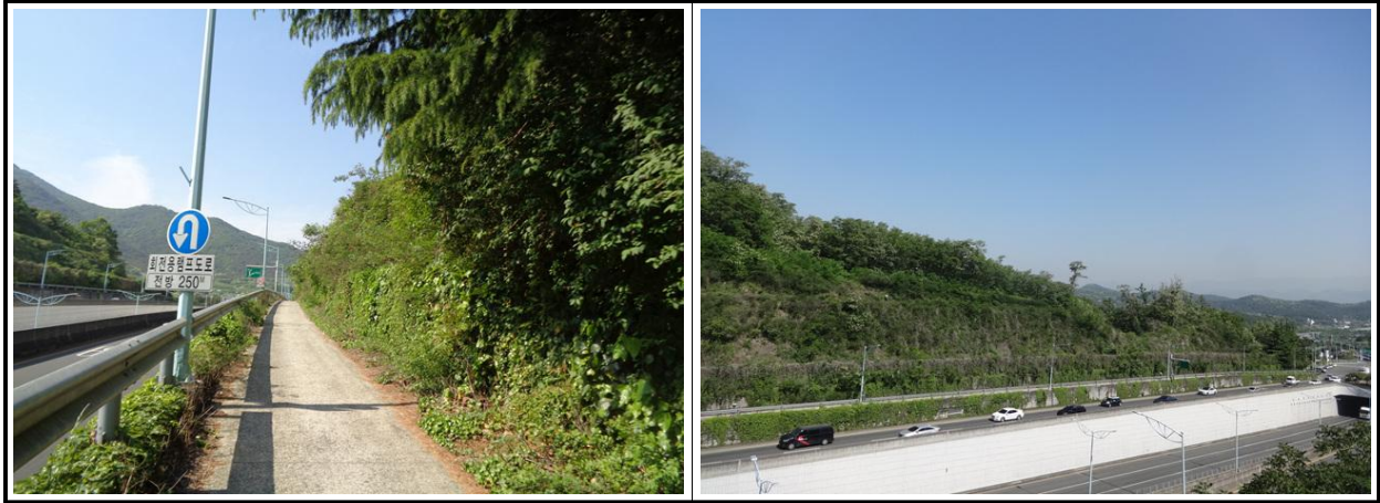
【그림 1.3.8】보호/보강시설 전경
